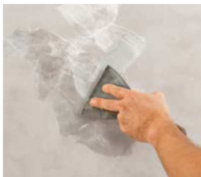
Kronen® Exquisit Finish dünnsschichtig in 1–2 Lagen aufspachteln.
