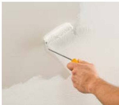
Grundieren mit Iso-Mineralgrund 309.
