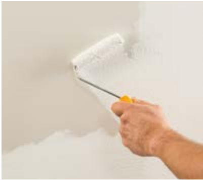
Grundieren mit Iso-Mineralgrund 309.
