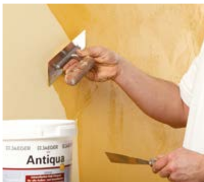
2. Lage Antiqua 968 eingetönt, leicht strukturiert.
