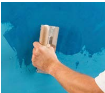
2. Lage Stucco Romano auftragen.
