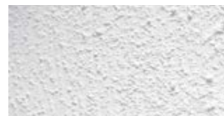
Struktur mit Malerbürste
