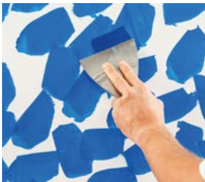
1. Lage Stucco Veneziano in Fleckspachtelung auftragen.
