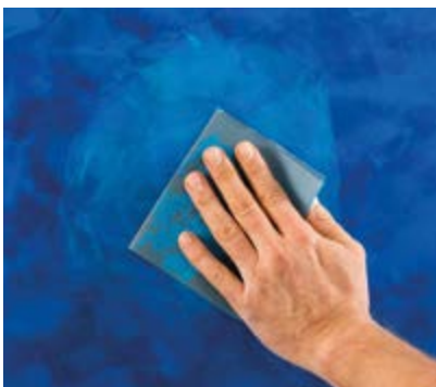
3. Lage Stucco Veneziano, anschließend schleifen (P1200).
