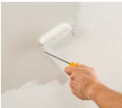
Grundieren der Fläche mit Jaeger Iso-Mineralgrund 309.
