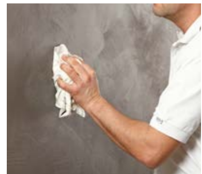
Überschüssige Seife mit einem Baumwolllappen aufnehmen.
