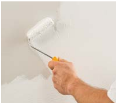
Grundieren mit Iso-Mineralgrund 309.
