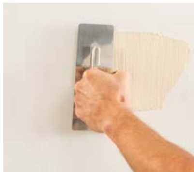
1. Lage Jaeger Travertino 930 mit der Glättkelle auftragen.
