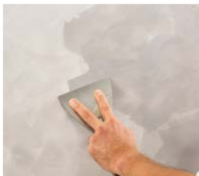
2. und ggf. 3. Lage Stucco Veneziano fleckig deckend aufbringen, anschließend schleifen (P1200).
