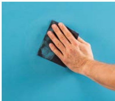
Fläche schleifen mit 320 er Schleifpapier.
