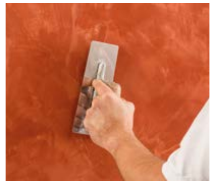
Fläche mit der Glättkelle unter Druck verpressen.
