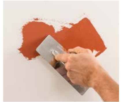
Fresco Veneziano gefleckt mit der Glättkelle aufspachteln.
