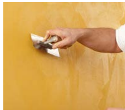
Fläche mit der Traufel verpressen.
