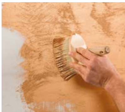
Jaeger Sabbia richtungslos auftragen.
