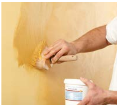
Auftrag der eingefärbten Antik Seife mit einem Pinsel oder der Kelle.
