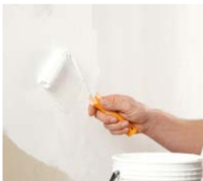
Grundieren der Fläche mit Jaeger Iso-Mineralgrund 309.
