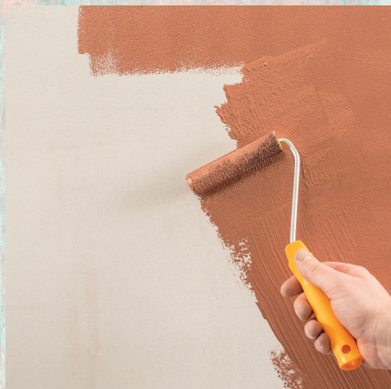
Grundfarbe in 2 Lagen auftragen.
