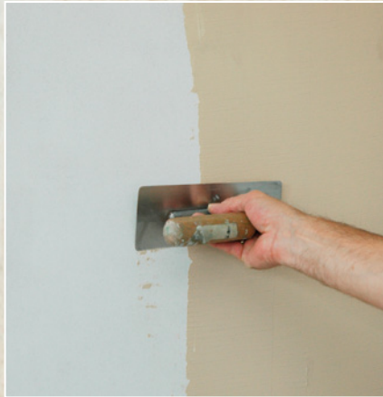
1. Lage Epoca Marmor 949, Farbton nach wahl, mit Glättkelle in Bahnen auftragen.
