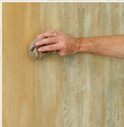
Überschuß der Seife mit fusselfreien Baumwollappen abreiben.
