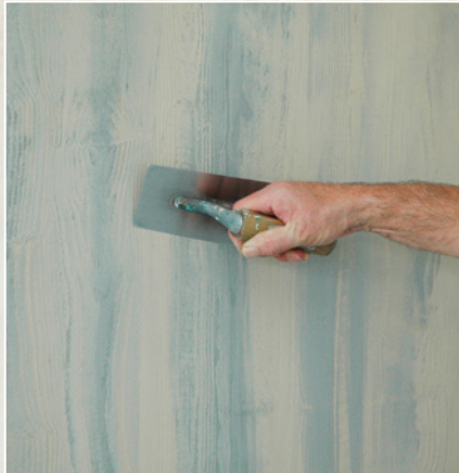
Nach einer Abluftzeit von ca. 30 min feuchte Oberfläche mit Glättkelle in Bahnen glätten.
