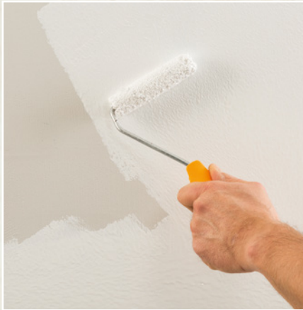
Grundieren der Fläche mit Jaeger Iso-Mineralgrund 309.
