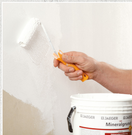
Grundieren der Fläche mit 309 Iso-Mineralgrund.
