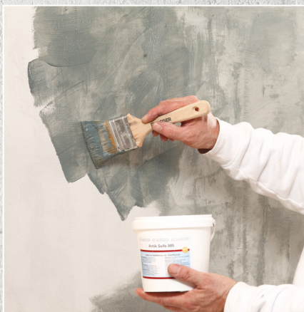
Auftragen der eingefärbten 985 Antik Seife mit einem Pinsel.
