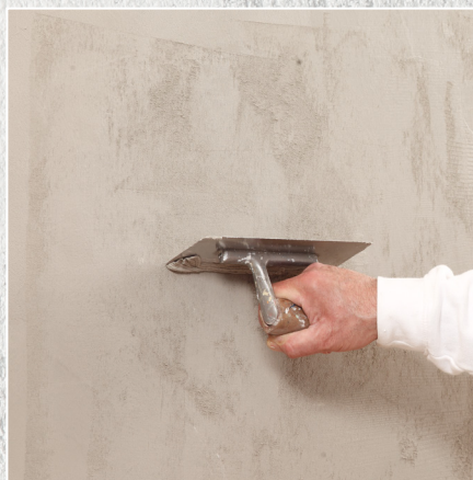
Strukturieren der Fläche mit der Traufel, anschließend glätten.
