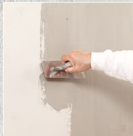
Auftragen der 2. Lage 949 Epoca Marmor in Bahnen.
