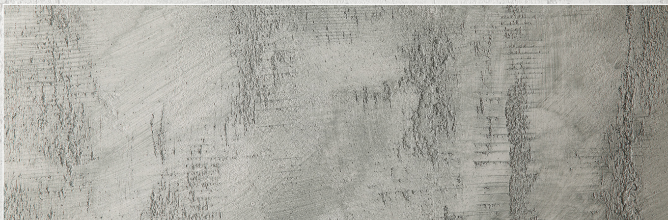
Strukturieren der Fläche mit der Traufel, anschließend glätten.
