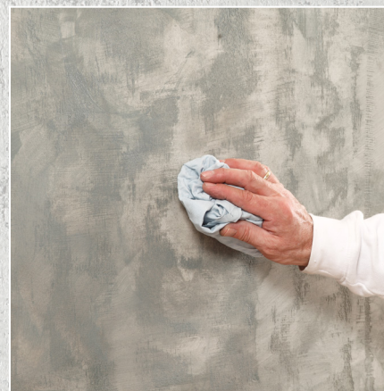
Überschüssige Seife mit einem Baumwolllappen aufnehmen.
