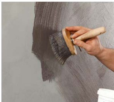
Auftrag der eingefärbten Antik Seife 985 mit einem Pinsel odder der Kelle.
