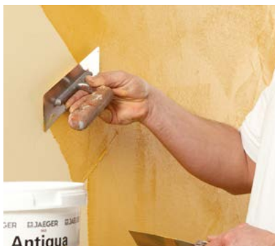
2. Lage Antiqua 968 eingetönt, leicht strukturiert.
