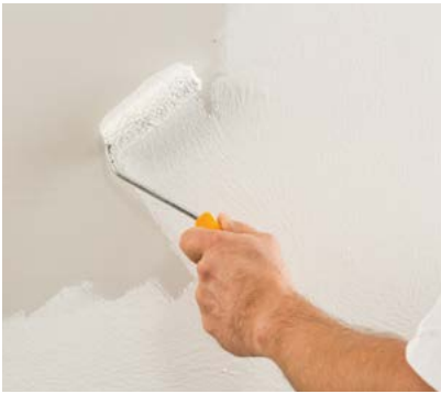
Grundieren mit Iso-Mineralgrund 309.
