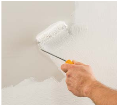
Grundieren der Fläche mit Jaeger Iso-Mineralgrund 309.
