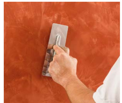
Fläche mit der Glättkelle unter Druck verpressen.
