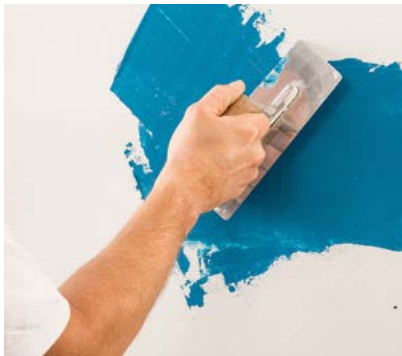
Nach dem Grundieren der Fläche mit Iso-Mineralgrund 309 wird die 1. Lage Stucco Romano mit der Traufel aufgetragen.
