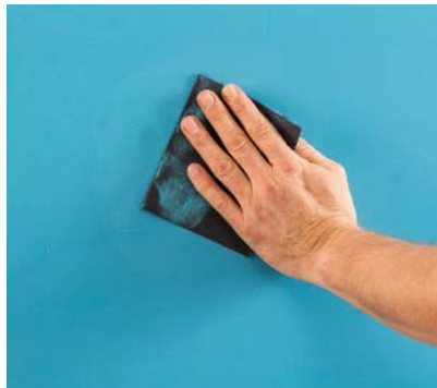
Fläche schleifen mit 320 er Schleifpapier.
