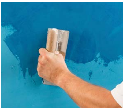
2. Lage Stucco Romano auftragen.
