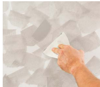
1. Lage Stucco Veneziano in Fleckspachtelung aufbringen.
