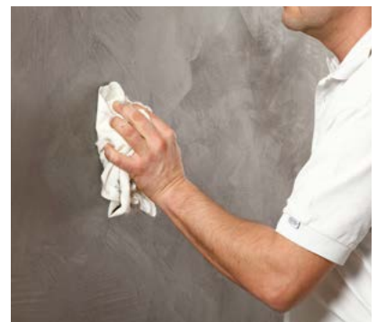
Überschüssige Seife mit einem Baumwoll-lappen aufnehmen.
