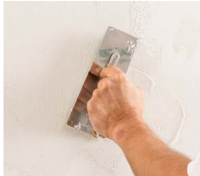
Eine Lage Antiqua Kalkputz mit der Traufel auftragen.
