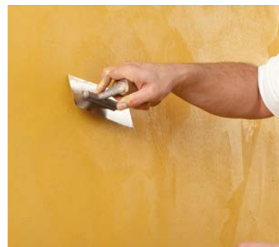
Fläche mit der Traufel verpressen.
