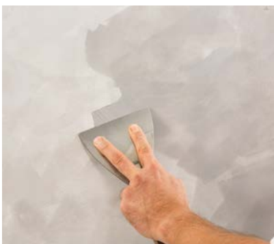
2. und ggf. 3. Lage Stucco Veneziano fleckig deckend aufbringen, anschließend schleifen (P1200).
