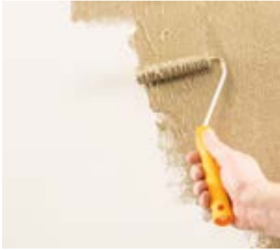
Eine Lage 928 Vesuvio mit 20% Wasser verdünnt auftragen.
