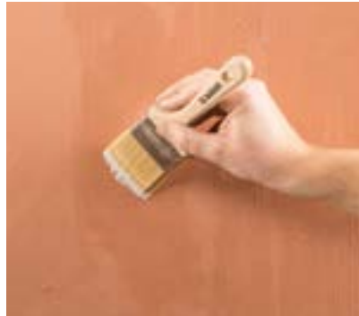
Aktivator mit Pinsel, Schwamm, Walze etc. fleckig aufbringen.
