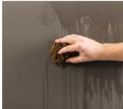
Aktivator mit Pinsel, Schwamm, Walze etc. fleckig aufbringen.
