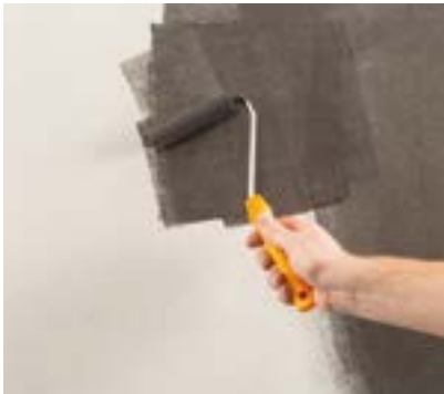
Grundfarbe in 2 Lagen mit 30% Wasser verdünnt auftragen.
