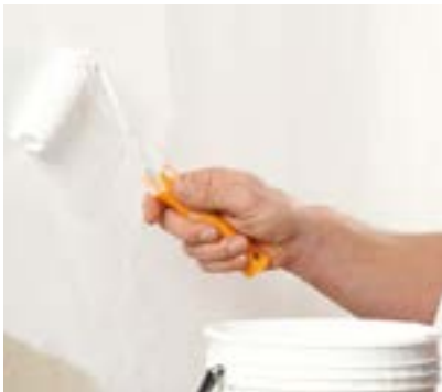
Grundieren der Fläche mit 309 Iso-Mineralgrund.
