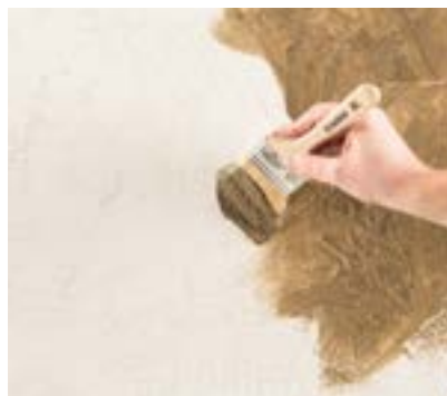
Auftragen der eingefärbten 985 Antik Seife.
