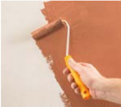
Grundfarbe in 2 Lagen auftragen.
