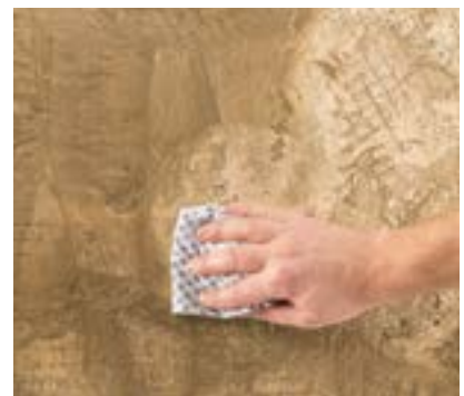
Überschüssige Seife mit einem Baumwollappen aufnehmen.
