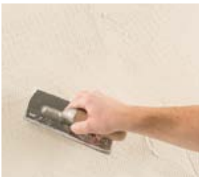
Die Fläche nach ca. 30 - 60 Minuten nochmals mit leichtem Druck glätten.
