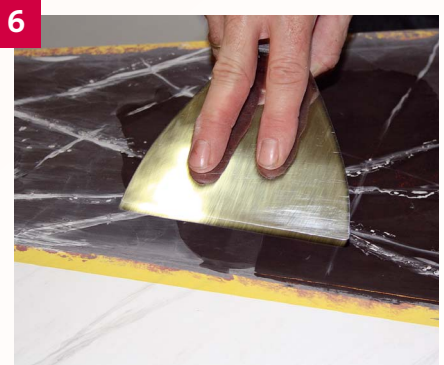
6 Nach einem weiteren Feinschliff wachst man die Fläche und poliert sie auf den gewünschten Glanzgrad auf.
