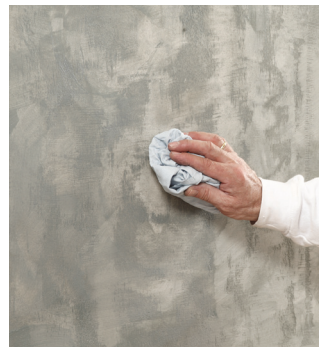
Überschüssige Seife mit einem Baumwolllappen aufnehmen.
