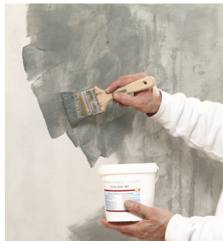
Auftrag der eingefrbten Antik Seife 985 mit Pinsel
