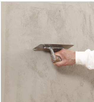
Flche mit der Traufel strukturieren
