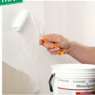
Grundieren der Flche mit Jaeger Mineralgrund 309.
